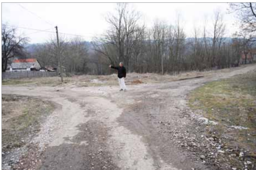
На реду асфалтирање у насељу Чешмарија
