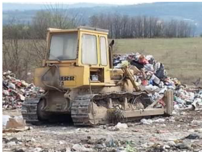
Слика 4.4.15-2. Булдозер за разастирање и равнање комуналног отпада на депонији отпада у Барошевцу
