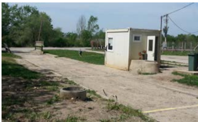
Слика 4.6.3-4. Друмска-колска „тепих“ вага (лево) и уређај за прање точкава возила и подвоза (десно)
