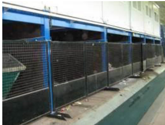
Слика 4.6.3-10. Предња страна боксева и транспортна трака за транспорт сортираног отпада ка балирки за секундарне сировине
