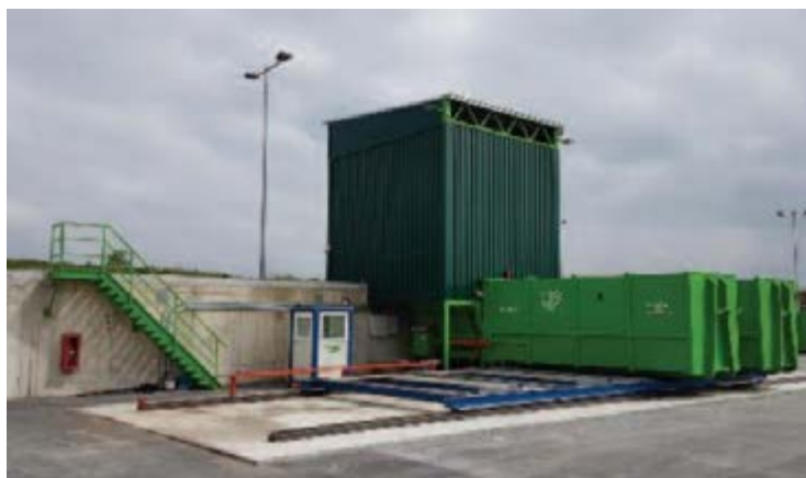
Слика 17.11.1-1. Изграђена аутоматска трансфер станица са колицима за позиционирање роло контејнера и кабином
