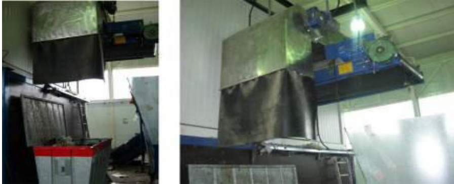
Слика 4.6.3-12. Електромагнетни сепаратор на излазу из тунела за сортирање
