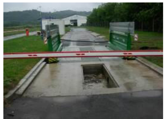
Слика 4.6.3-4. Друмска-колска „тепих“ вага (лево) и уређај за прање точкава возила и подвоза (десно)
